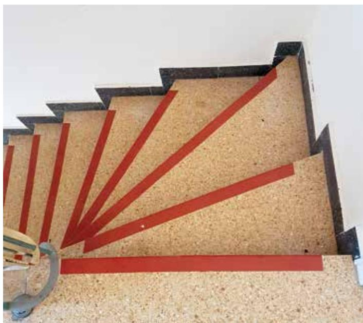
Die Stufen sind durch die Markierungen an der vorderen Stufenkante gut zu erkennen. © LRA Bamberg
